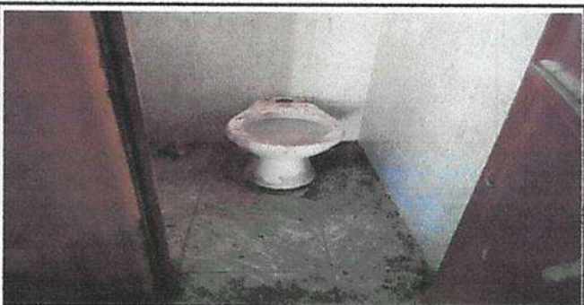
Foto 5: SUSTITUCION DE INODOROS
