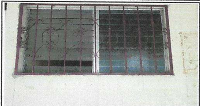
Foto 2: MANTENIMIENTO A BALCONES
